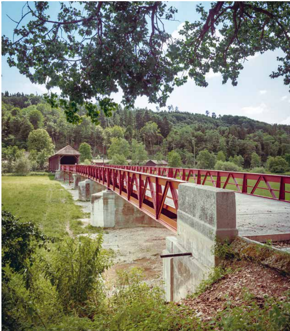
Lange lag das Augenmerk auf der gedeckten Holzbrücke, die Stahlkonstruktion wurde sich selbst überlassen. Mit der aufwendigen Sanierung 2020/21 rückte die Vorlandbrücke in den Fokus.
